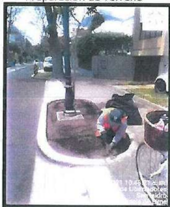
Preparación de Terreno
